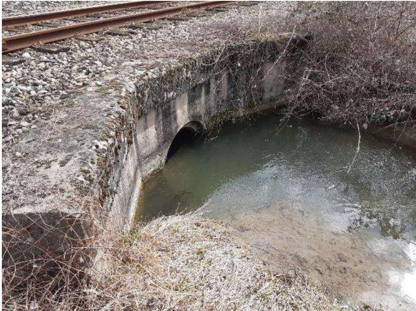
*Figure 13 : Ouvrage traversant la voie ferrée*
